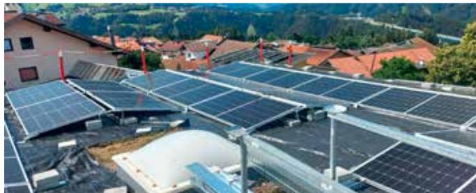
172 PV-Module in Ost-West-Ausrichtung erzeugen mit einer Generatorfläche von 322 m<sup>2</sup> rund 65 kWp elektrische Energie
